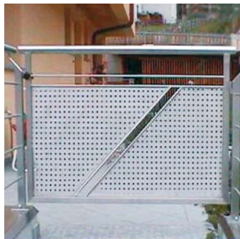
Recinto del giardino di un residence, Valle S. Silvestro
