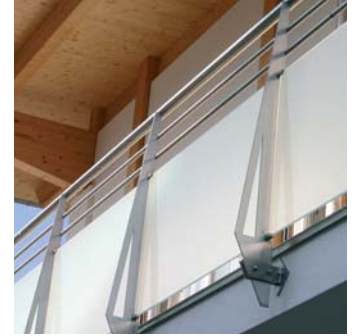
Dettaglio della ringhiera di un balcone, Inox Design, Monguelfo
