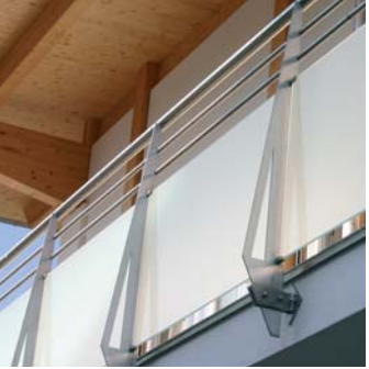
Detail Balkongeländer Inox Design, Welsberg
